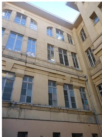
La struttura, risalente ai primi anni del '900, presenta molte criticità dal punto di vista termico: le pareti perimetrali in particolare sono non isolate come anche le altre componenti strutturali ad eccezione della copertura recentemente ristrutturata.
